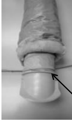
Positionner le conduit sur les piquages jusqu'à la rainure A
