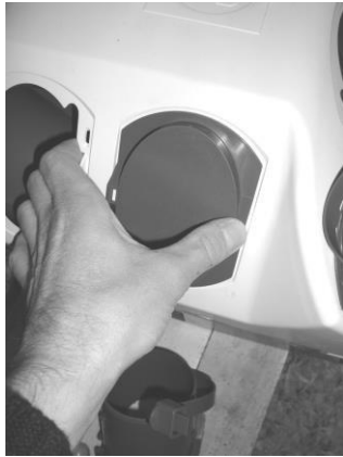
Opturer les piquages non utilisés à l'aide des bouchons (Qté:4).
