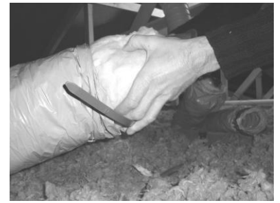
Positionner l'isolant jusqu'à la rainure A
