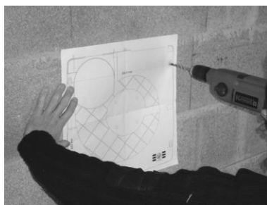
Perçer les trous de fixation
